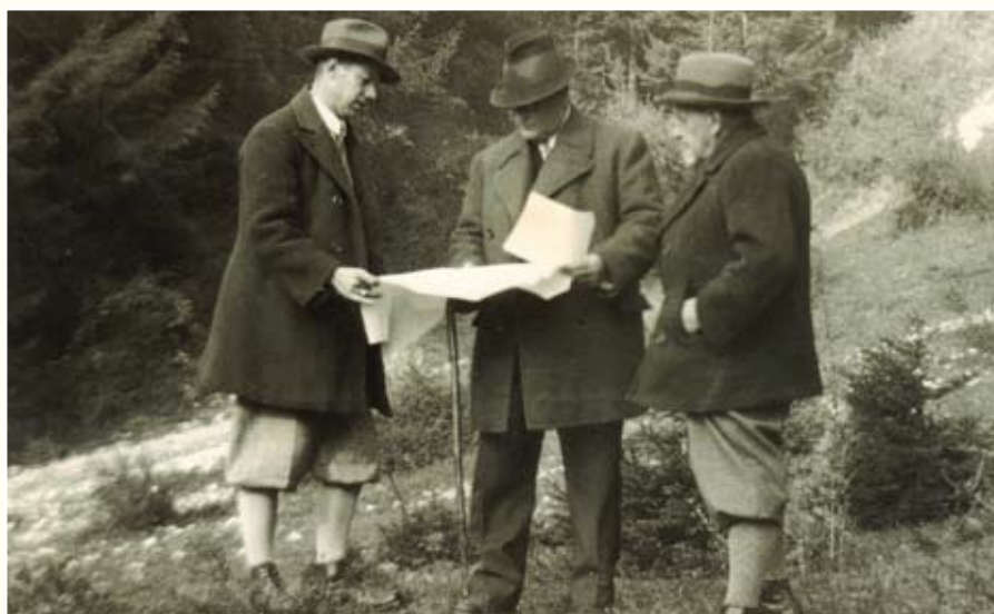
Generaldirektor DI Backhaus (Mitte), HR Julius Klein (re) und ein Vermessungsingenieur bei der Festlegung des Stollenschlagpunktes.
