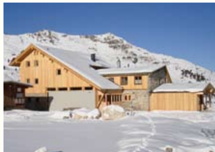
OeAV-Hall Schutzhütte Lizumerhütte „neu“ im Jänner 2007, nach Generalsanierung - Foto: oev hall
