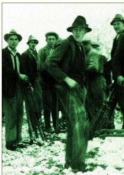
Knapp vor Winterweintrub wurde mit den ersten Arbeiten begonnen.
