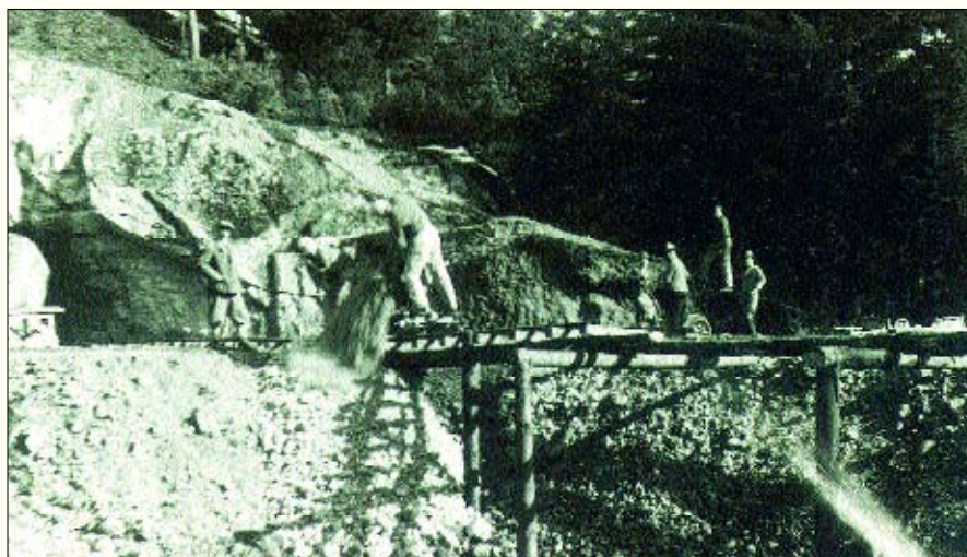
Das Ausbruchmaterial wurde unmittelbar vor dem Stollenloch abgelagert.
